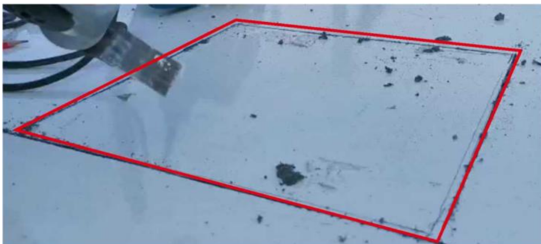
Разметка и подготовка проёма в крыше
