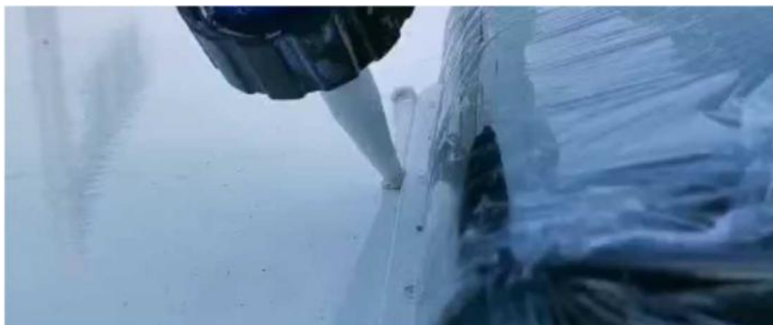
Герметизация крепежа и стыка фланца
