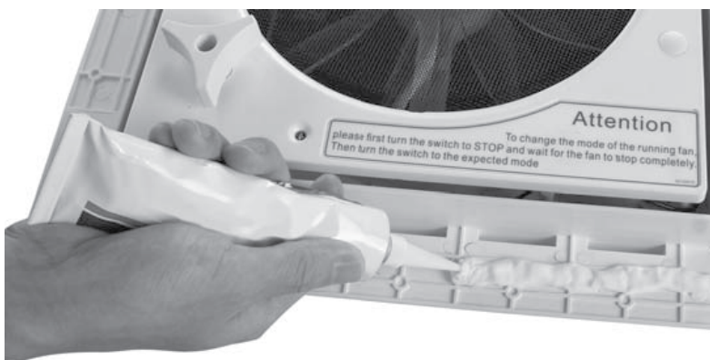
Нанесение герметика на нижнюю сторону фланца
